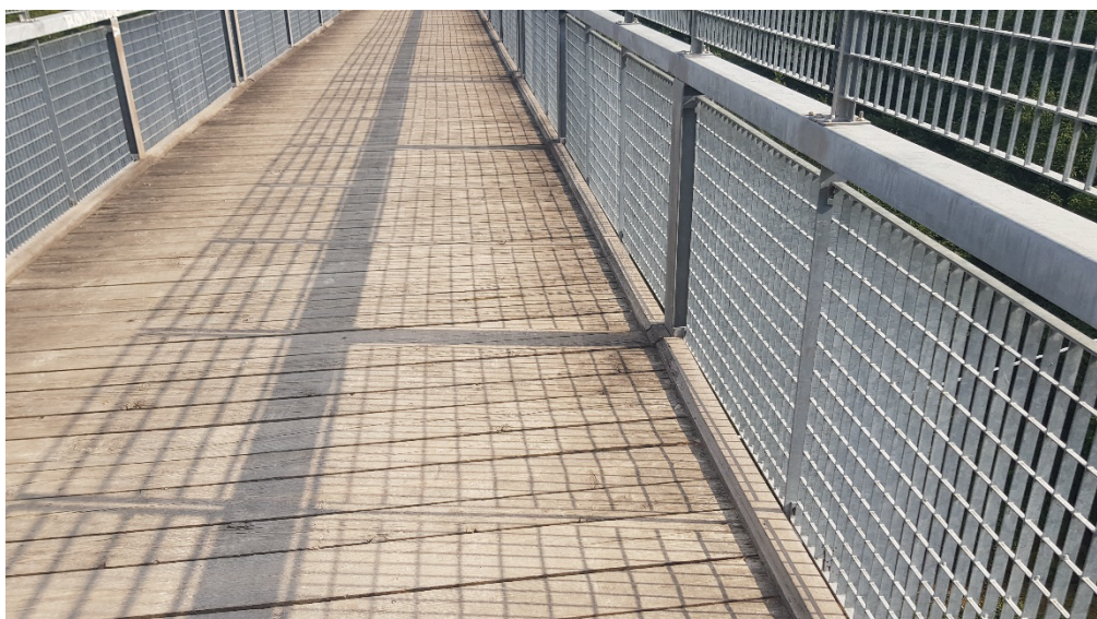
Tavolato esistente – Ponte esistente sul torrente Posina
