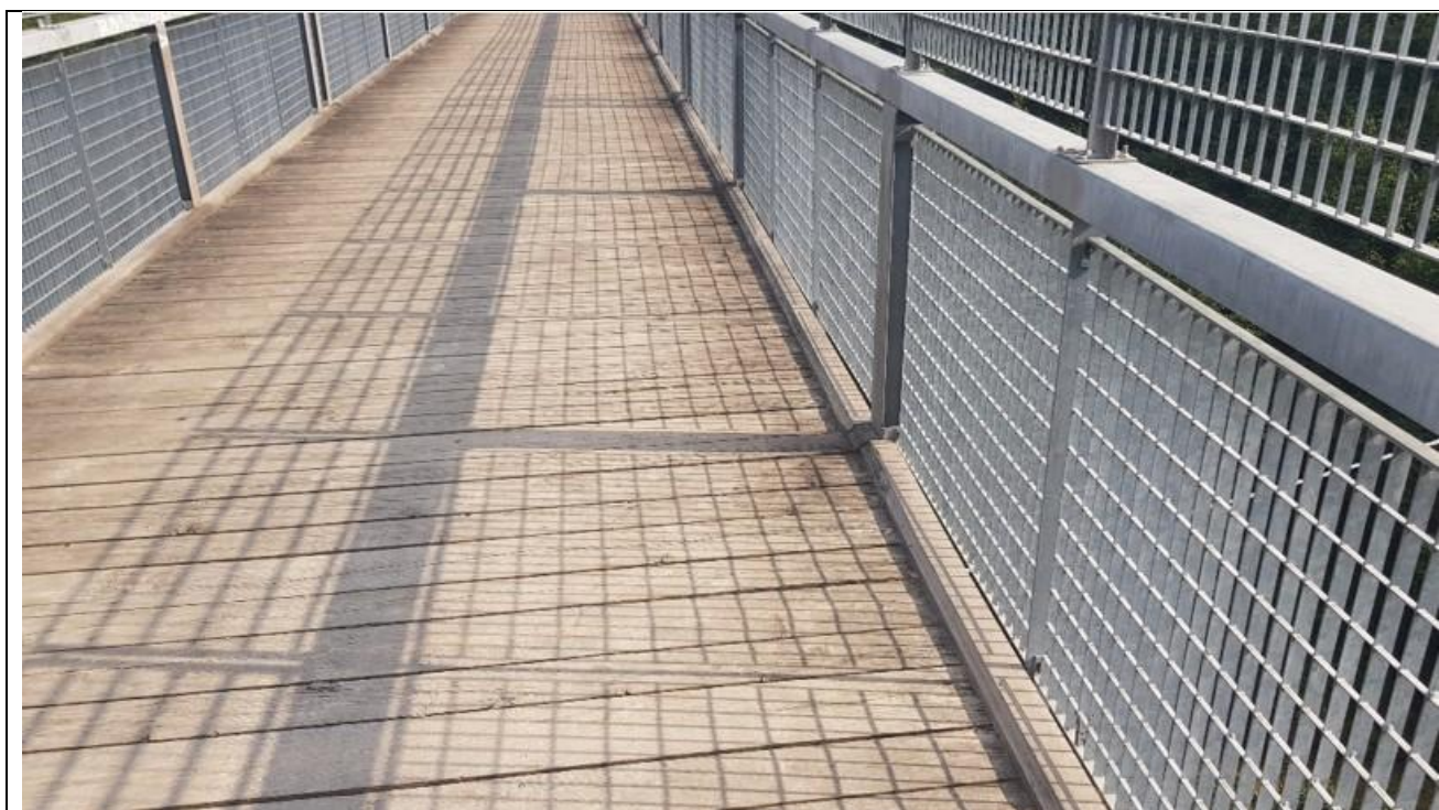
Tavolato esistente – Ponte esistente sul torrente Posina
